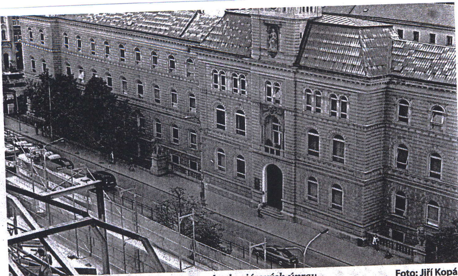
Soudní budova v Olomouci se dočká letos bezbariérových úprav.
